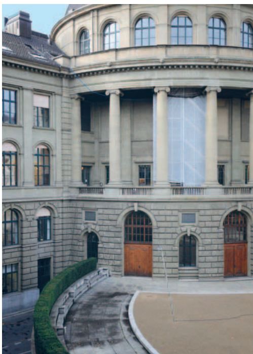
Auf dem Balkon um das Auditorium Maximum wurde ein Gerüst aufgestellt, um die Decke aufzuschneiden. (Bild Josef Kuster/ETH Zürich)
